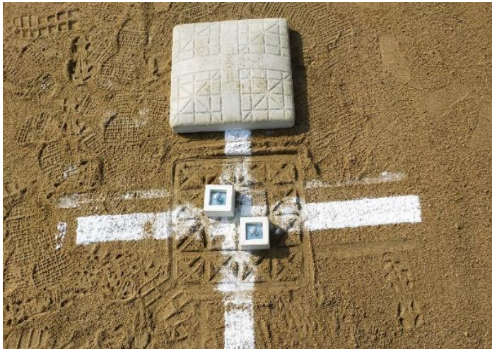
ベース固定金具 (ベース設置前)
